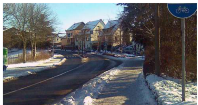
Abgestumpfte Schneedecke auf Rad-/Gehweg
