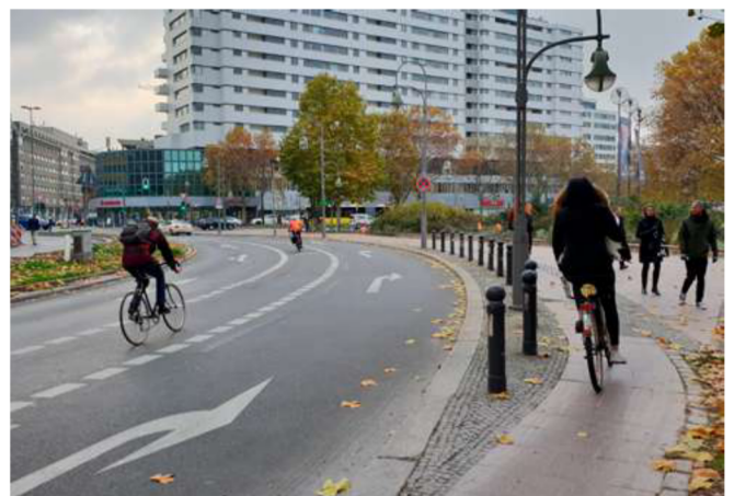
Radfahrstreifen zwischen den Fahrstreifen für den Kfz-Verkehr
