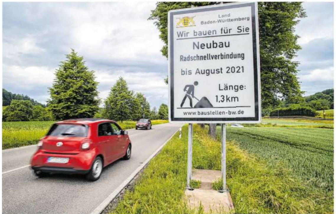
Heute starten die Bauarbeiten am Radschnellweg zwischen Ebersbach und Reichenbach/Fils.
