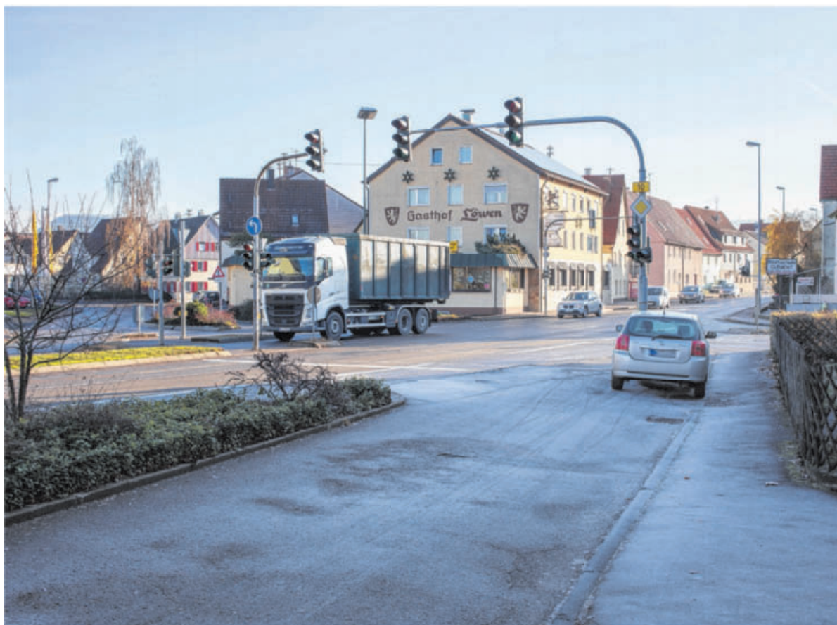
Die Straßen treffen an der Löwenkreuzung teilweise in einem spitzen Winkel aufeinander. Das macht das Anlegen eines Kreisverkehrs kompliziert.
